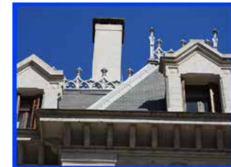
Arreglo de una de las ventanas del edificio ubicado en Paseo Colón 982
