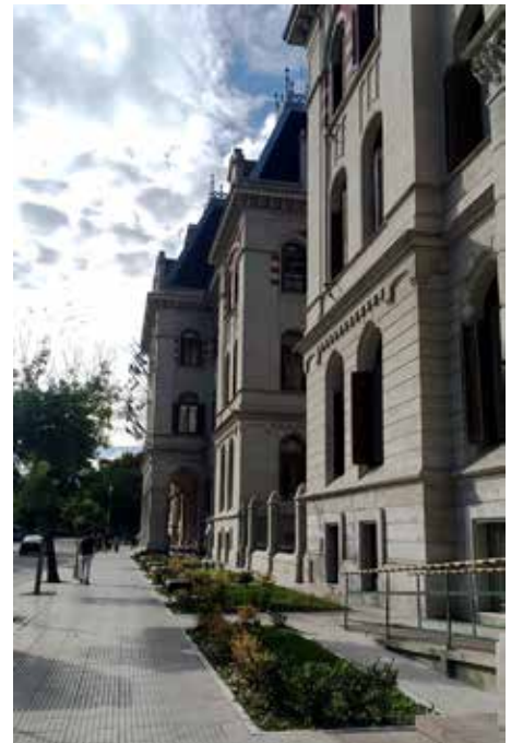
Colocación de cámaras de seguridad sobre fachadas de ambos edificios
