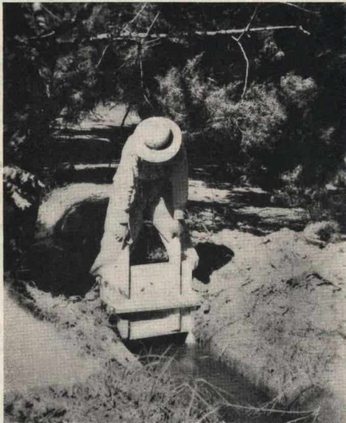
FIG. 6. — Para las acequias menores, las sobreacequias y para las mismas regueras situadas dentro del "paño", las compuertas simples, como la del grabado, son siempre necesarias. Conviene que el marco sea de madera dura, pero la hoja puede confeccionarse con madera de álamo, convenientemente impermeabilizada y pintada.
