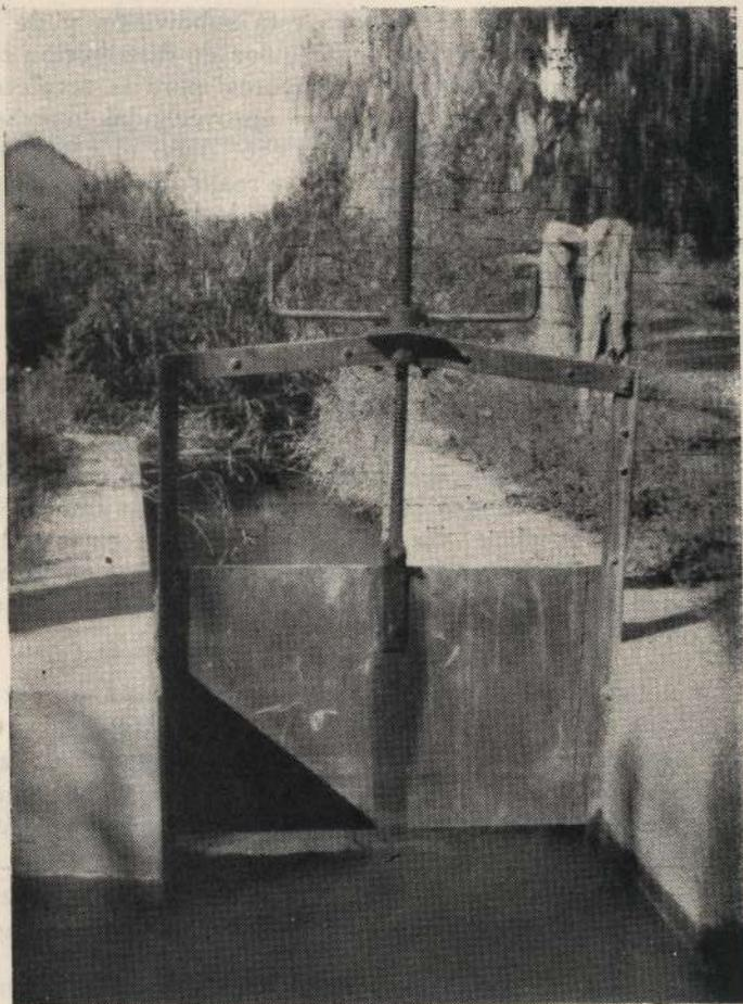
FIG. 5.—Las compuertas de toma de hijuela, con preferencia deben ser metálicas, de tipo regulable. De acuerdo con el giro que le imprime la tuerca "mariposa" puede establecerse prácticamente una relación directa sobre el número de roscas y el caudal de paso o de entrada. No obstante, se aconseja el uso de aforadores, inmediatos a las compuertas.
