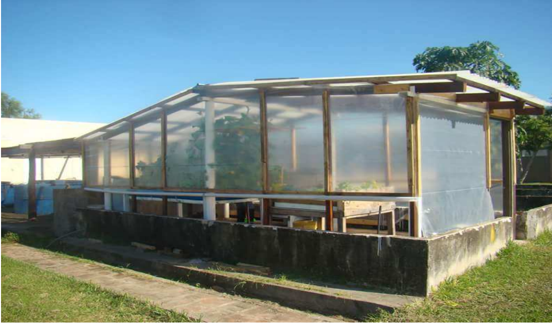
Figura 14. Invernadero de pequeña escala-Módulo de experimentación, instalado en CENADAC.
